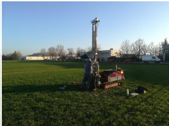
Figura 9: posizionamento delle indagini CPTU3 e CPTU4.
