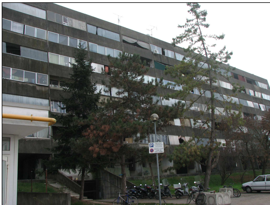
Blocchi 4-5-6 allo stato attuale - Lato est
