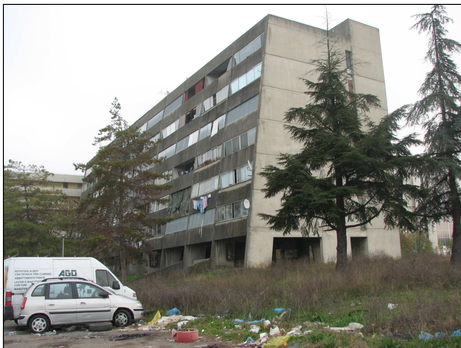
Blocchi 4-5-6 allo stato attuale - Lato sud
