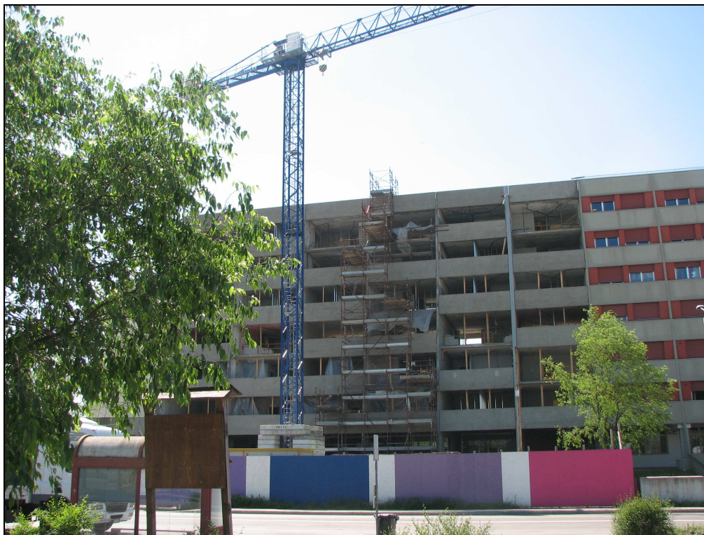
Blocco 3 in fase di ristrutturazione
