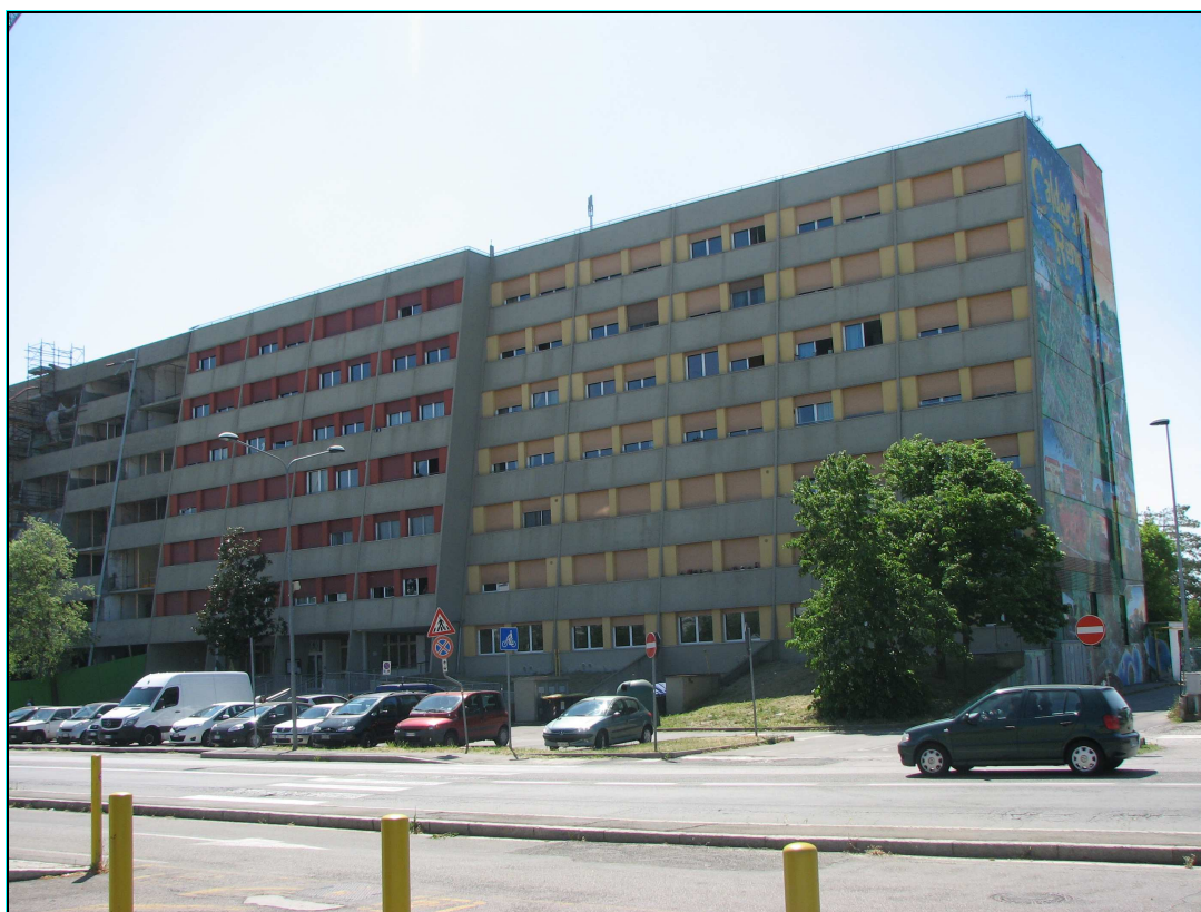
Blocchi 1 e 2 Ristrutturati
