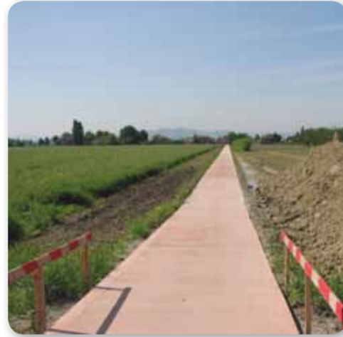
I lavori del sottopasso ciclopedonale
